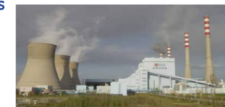
Tuoketuo Power Plant, China
